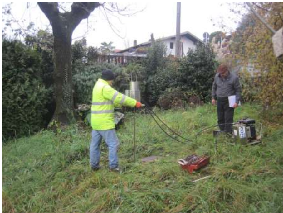
Esecuzione in corso della Prova P3
