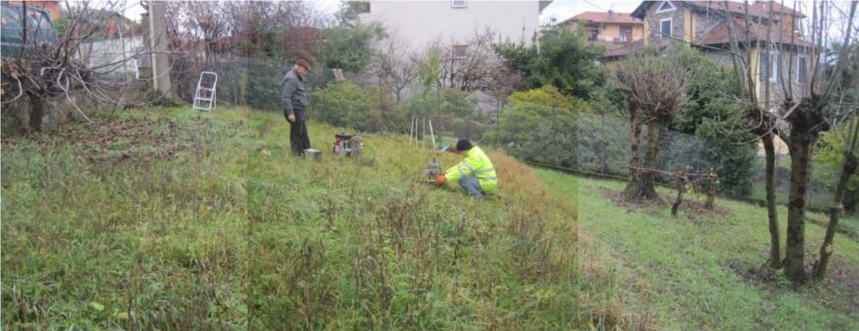
Panoramica da Ovest del pendio dell'area d'intervento, nel corso dell'esecuzione della Prova P2
